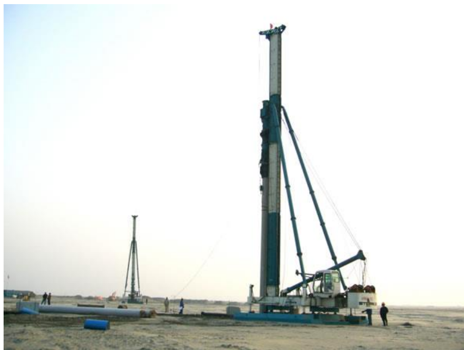
Figura 8.4: Bate Estacas para cravação de estaca pré-moldada
