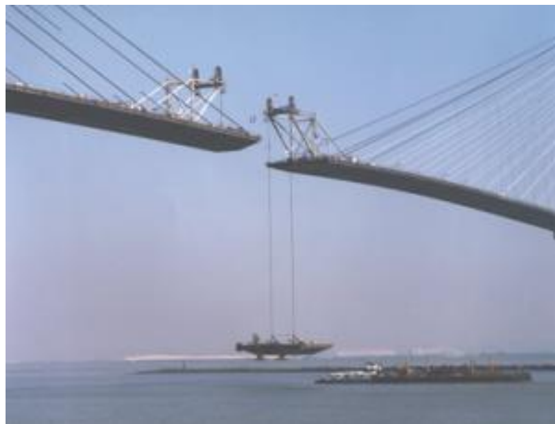
Figura 3.23: Ponte Estaiada com Aduelas Pré-moldadas
