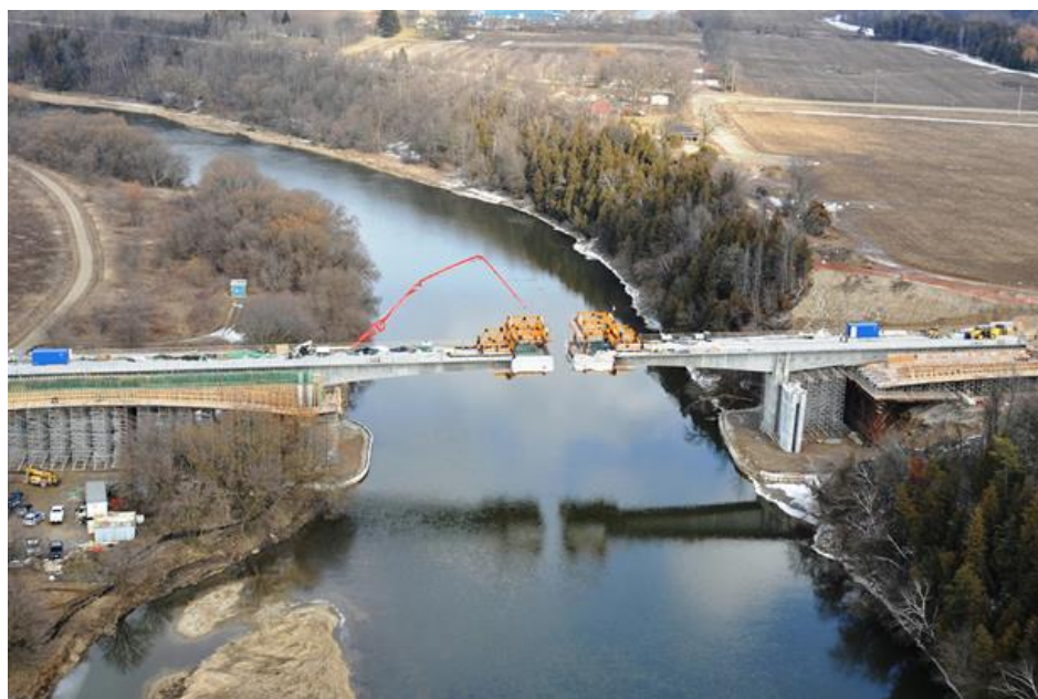
Figura 4.1: Método dos balanços sucessivos
