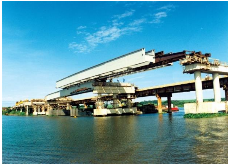
Figura 3.18: Exemplo de Ponte Empurrada
