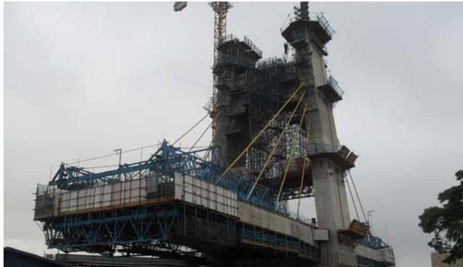
Figura 3.22: Ponte Estaiada com Aduelas Moldadas in loco
