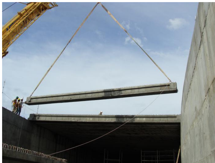
Figura 3.14: Lançamento de viga com Guindaste
