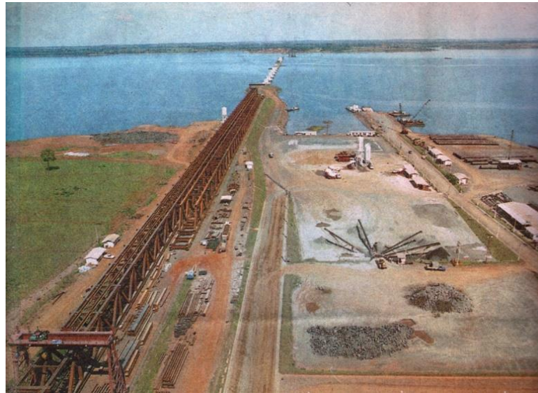
Figura 3.19: Canteiro de Obras de Ponte Empurrada
