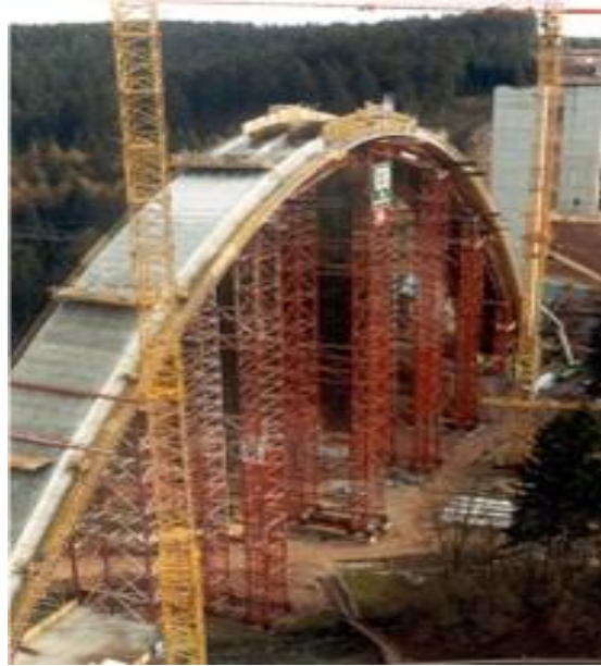
Figura 3.15: Escoramento Fixo de Uma Ponte em Arco
