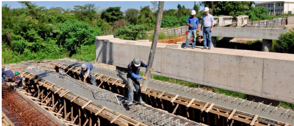
Figura 3.12: Ponte em Viga Moldada no Local
