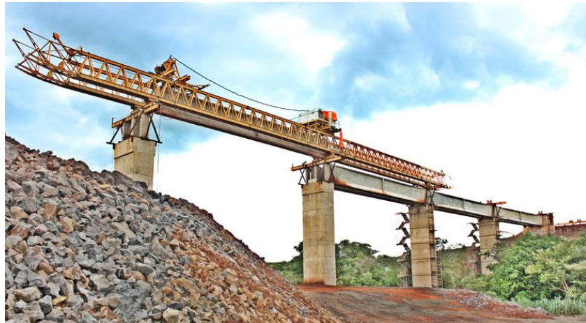
Figura 3.13: Lançamento de Viga com Treliza Lançadeira
